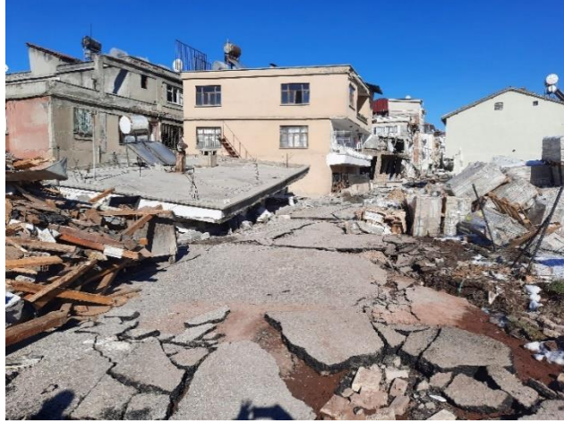
Şekil 9. Gölbaşı ilçesinde gözlenen yüzey faylanmasına örnekler.
