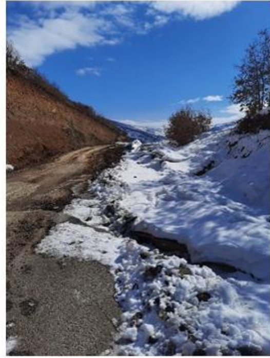
Şekil 20. Ericcek Esendere Vadisi 1.8 m tepe ötelenmesi ve Soysallı Yeniköy yolunda yolu dar açıyla kesen fay kontrollü yolda deformasyon.
