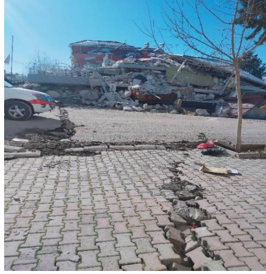
Şekil 29. Gaziantep İslahiye ilçesinde yüzey deformasyonlarının neden olduğu yapısal hasarlar.
