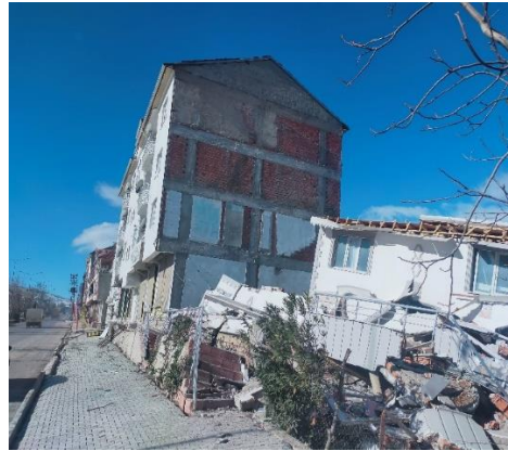
Şekil 28. Adıyaman Gölbaşı ilçesinde sıvılaşma nedeniyle hasar görmüş yapılar.
