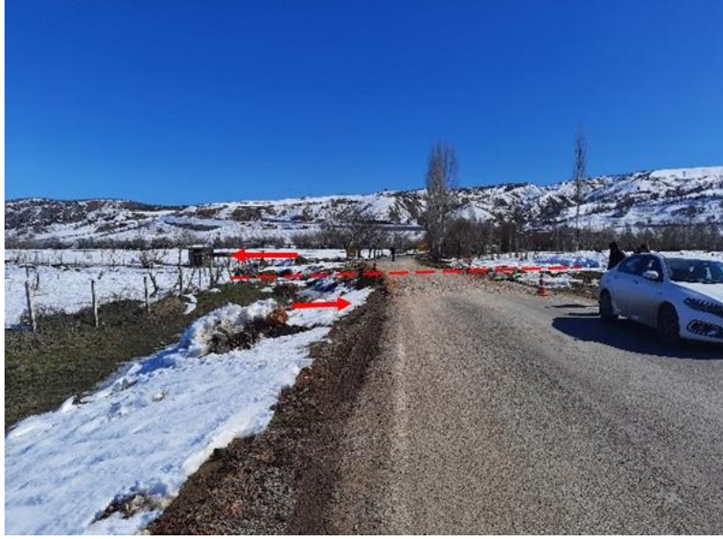
Şekil 11. Gölbaşı-Çağlayancerit yolu üzerinde gözlenen sol yanal ötelenme.
