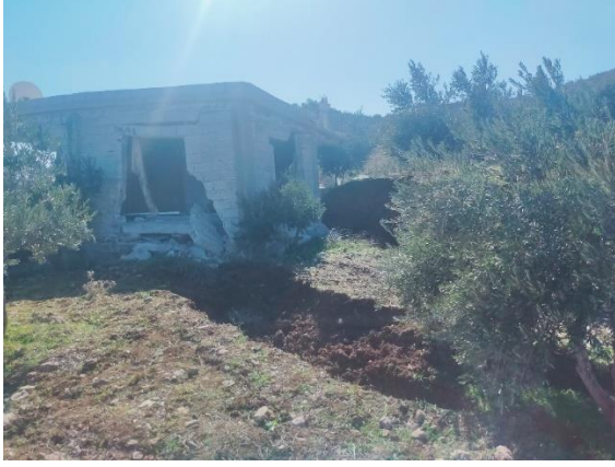
Şekil 29. Gaziantep İslahiye ilçesinde yüzey deformasyonlarının neden olduğu yapısal hasarlar.
