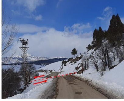
Şekil 19. Elbistan Depremine ait sol yanal ötelenmeler. a: Saylan Ahmetçik Yolu Salyan çıkışı (4.2 yanal ötelenme, 1m Kuzey Bloкта düşme) b: Salyan-Gücüksu arası.
