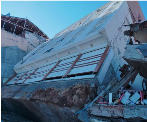
Şekil 28. Adıyaman Gölbaşı ilçesinde sıvılaşma nedeniyle hasar görmüş yapılar.
