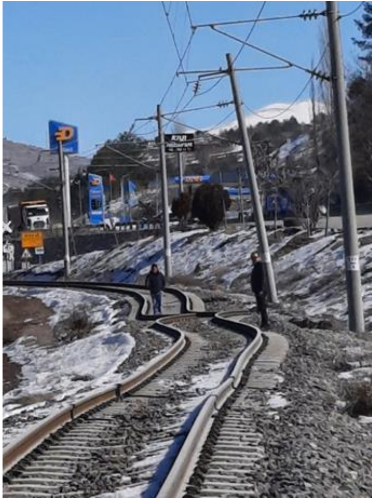
Şekil 8. Gölbaşı ilçesi Malatya girişinde demiryolunda gözlenen deformasyon.
