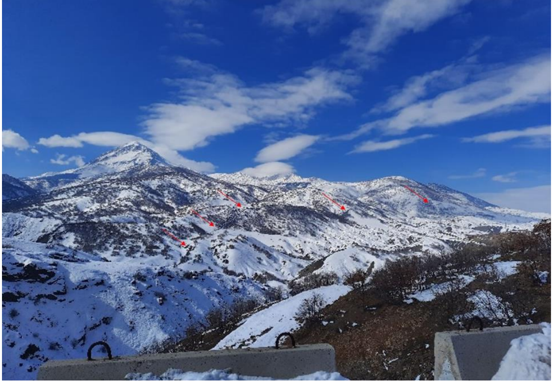
Şekil 21. Kandil Barajı Güneyinden Ericcek yönüne bakış.
